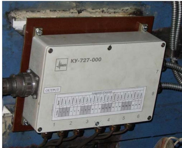
Рис. 1.3. Кроссировочное устройство УК-727. Внешний вид.
