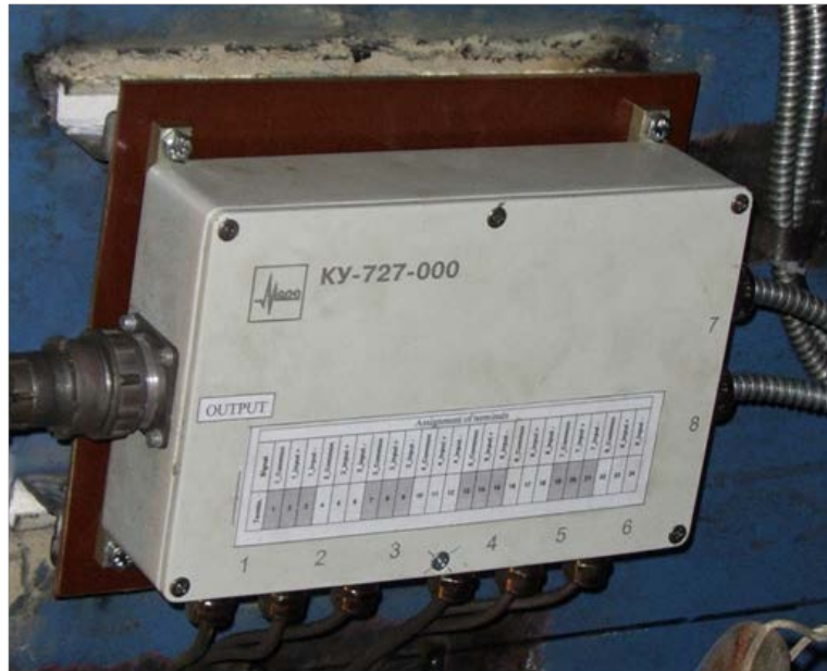
Рис. 1.3. Кроссировочное устройство УК-727. Внешний вид.
